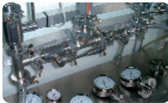
Banco de calibración y llenado de separadores
